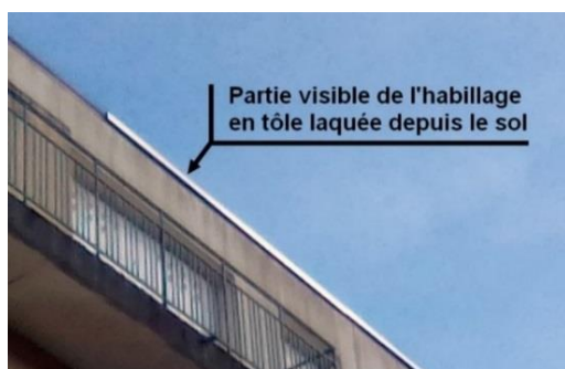
Pose partielle sur une toiture
