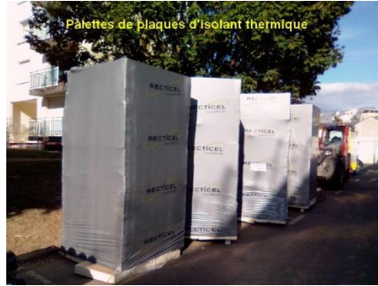
Palettes de plaques d'isolant thermique Isolant thermique en mousse de polyuréthane R : 4,50 m 2 .k/w
