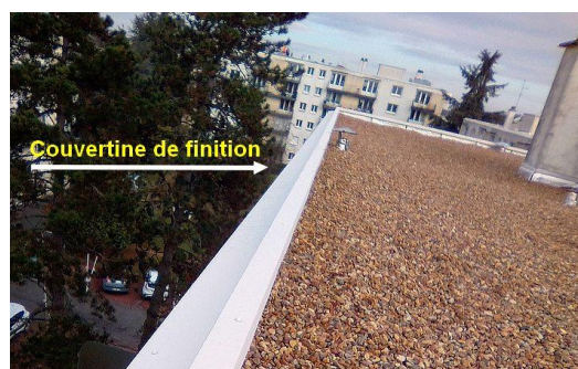
Sur le toit de Bleuet
