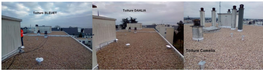
Des toitures terminées
